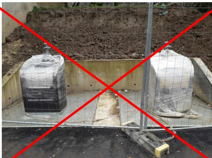
De même, il conviendra d'aménager les bornes de sorte d'éviter les infiltrations d'eau à l'intérieur des cuves (joint autour des plateformes, nivelé, etc.).
